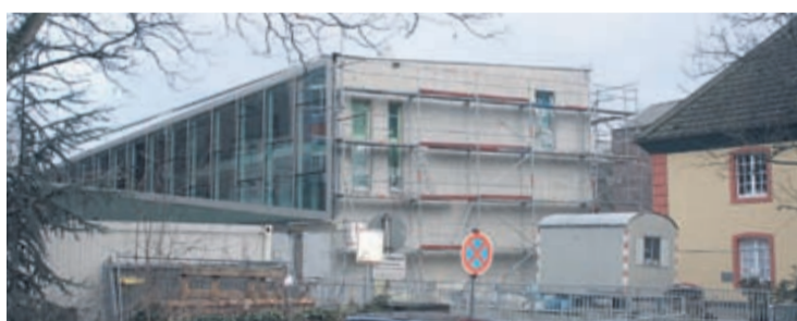
Innen so gut wie fertig, außen noch Baustelle: der Erweiterungs-trakt der Duisburger Abtei. Fotos: frm/uw
